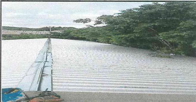
Foto1: Sustitución de lámina completa.
