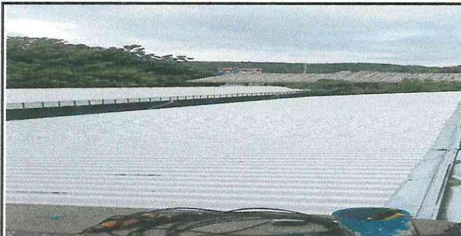
Foto 2: Sustitución de lámina de todos los módulos
